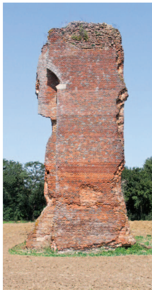
Vestiges du château d'Authumes : montant droit de la tour-porche. On distingue près du sommet le départ de l'arc de l'assommoir. Sur le mur du second plan, un arrêt de maçonnerie vertical est le vestige de la fente de flèche du pont-levis, qui s'ouvrait au second niveau de la tour.
